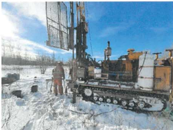
Vue de l'emplacement du forage 23F12
