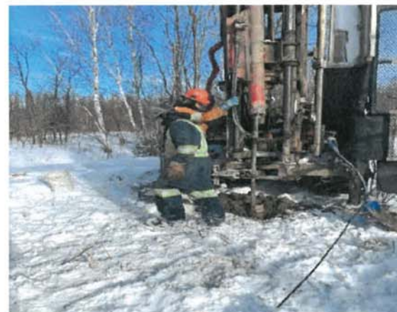
Vue de l'emplacement du forage 23F9
