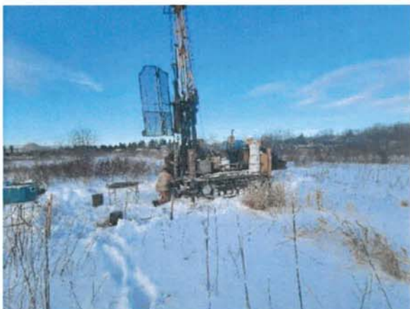
Vue de l'emplacement du forage 23F8
