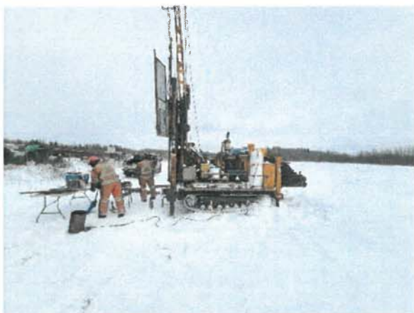
Vue de l'emplacement du forage 23F2
